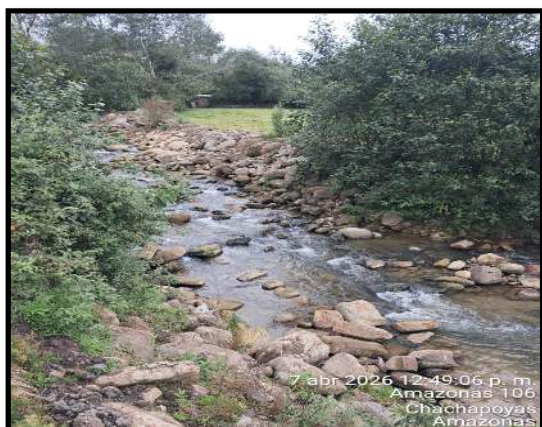
Imagen1.-Se aprecia colmatacion del cauce y densa vegetacion de cauce
